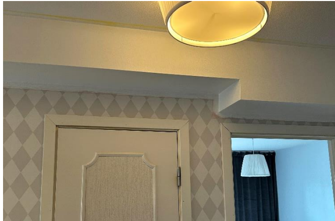
Inbyggda ventilationskanaler i hall.
