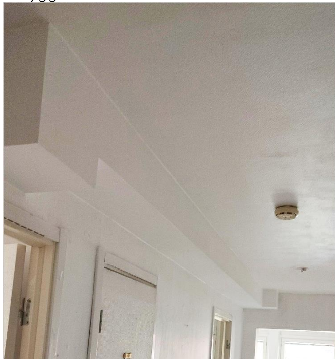
Inbyggda ventilationskanaler i hall.
